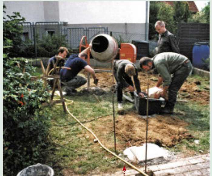
Die Punktfundamente werden gesetzt. Wichtig: Sie müssen zueinander im Wasser stehen.
