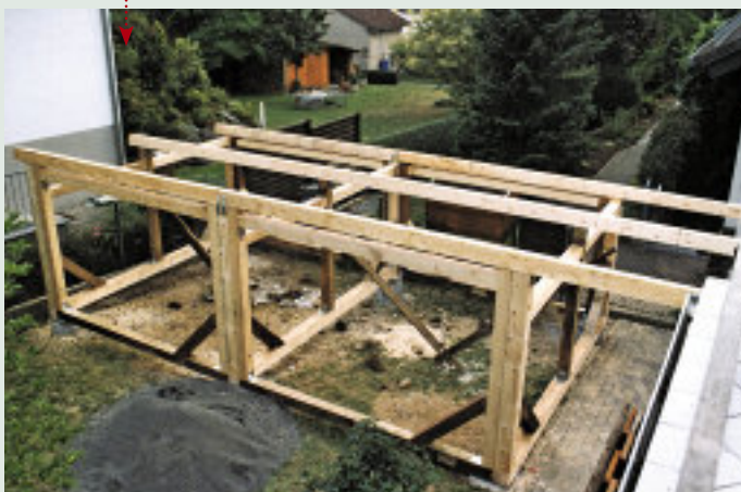
Die Dachpfetten sind gesetzt. Allmählich nimmt der Zwinger Gestalt an.
