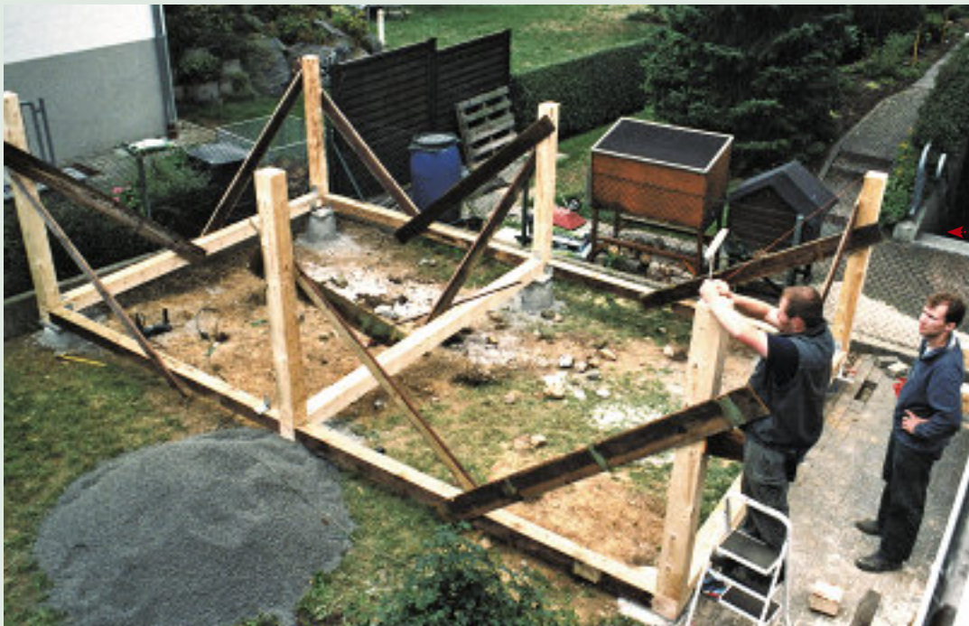
Die Dachpfetten sind gesetzt. Allmählich nimmt der Zwinger Gestalt an.
