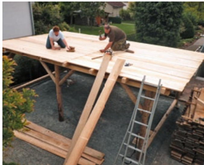
Oben: Mit Hilfe von Fixierhölzern werden die Ständer „in Waage“ gestellt.
