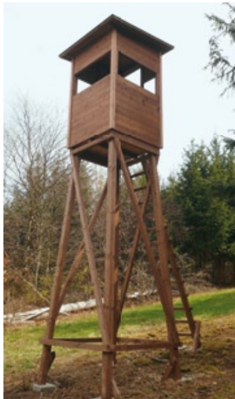
Die offene Kanzel steht auf Betonplatten, damit die Hochsitzstangen nicht faulen
